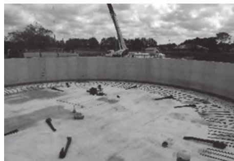
写真-6 配水調整槽(PCパネル構造)のPCパネルの組立完了、底版の鉄筋組立状況
