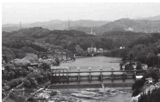
昭和32年に完成した明治用水頭首工
