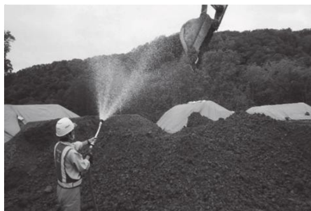
写真-9 ストックパイル含水比調整状況
