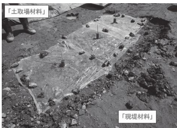
写真-13 接合部試験後の現場透水試験の状況 (表面からの蒸発を防ぐためビニールシートをかけて試験を実施)
