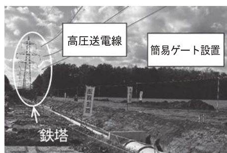
写真-3 釧路第4工区 支線排水路の施工状況 (高圧送電線近くで行う作業の安全対策)
