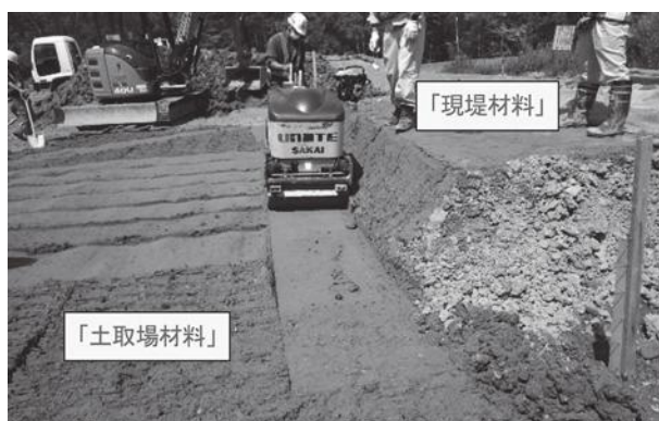
写真-11 接合部の試験状況
