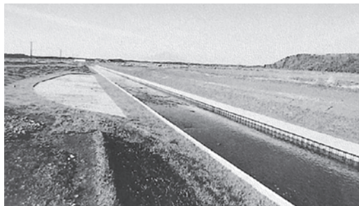
サロベツ第1地区第1号幹線排水路完成状況
