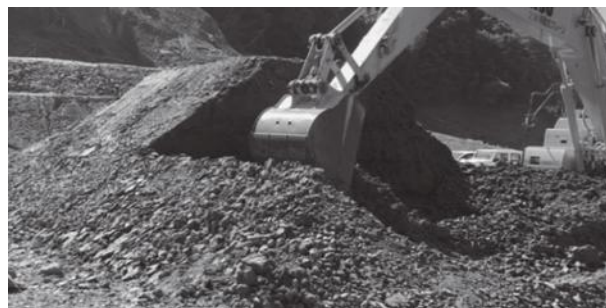
写真-5 ブレンドパイル切り崩し状況
