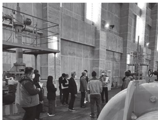
写真-6 霞ヶ浦揚水機場 ポンプ施設 説明状況
