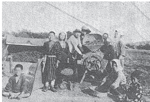
麦の穂を焼いて落し、集めてあるものを箕(み)で足踏機に入れ麦と殻を分離している作業風景(大正9年頃)
