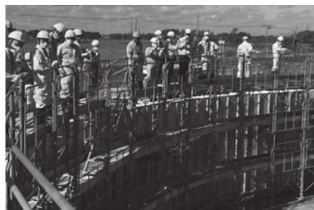
写真-5 足場の上から配水調整槽(現場打ちRC構造)の施工状況を見学
