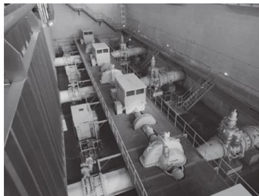
写真-4 第2揚水機場
