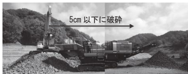
写真-4 自走式クラッシャによる粗粒材破碎状況
