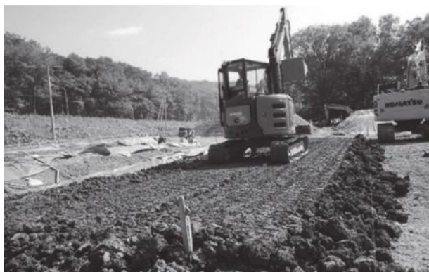
写真-8 0.1m³級バックホウによる敷き均し状況
