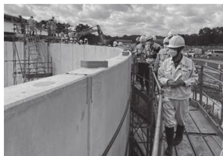
写真-7 足場の上から配水調整槽(PCパネル構造)の施工状況を見学
