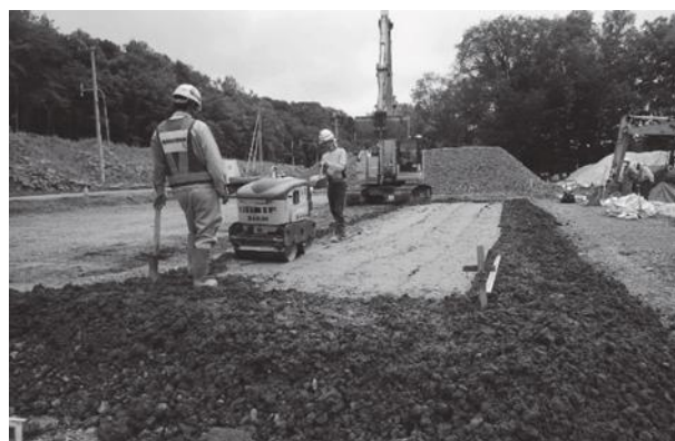
写真-10 1t級振動ローによる転圧状況
