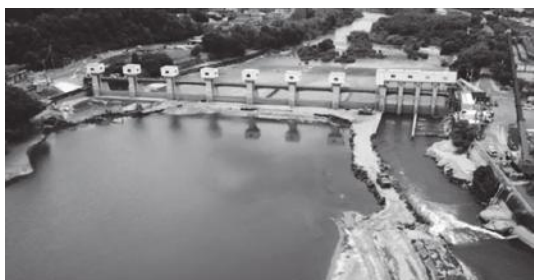
令和4年漏水による調査中の明治用水頭首工
