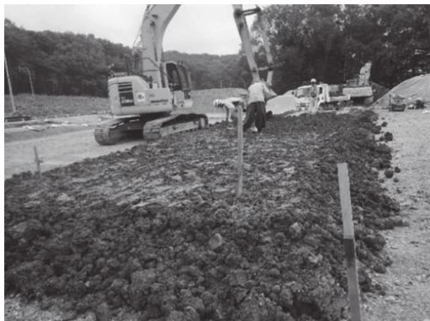
写真-7 材料まき出し状況 (盛立場所が狭小であることからバックホウによりまき出しを行っている状況)
