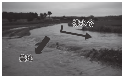
写真-1 平成28年8月20～21日の被害状況
