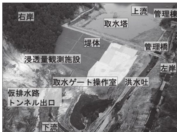
写真-1 厚真ダム堤体被災状況写真
