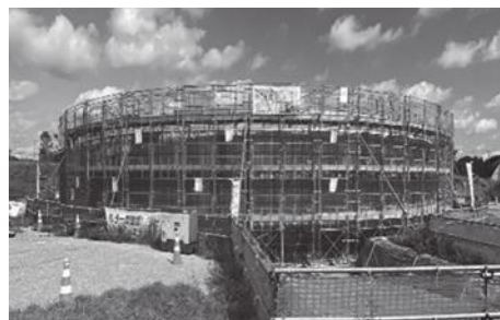
写真-4 配水調整槽(現場打ちRC構造)の施工状況 (側壁の鉄筋・型枠組立の完了)
