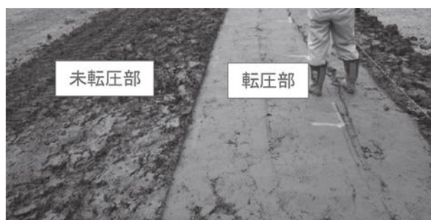
写真-6 現堤鋼土の転圧状況 (材料の粘性が強く、1 t級振動ローラでは十分な転圧効果が得られなかったと判断した)
