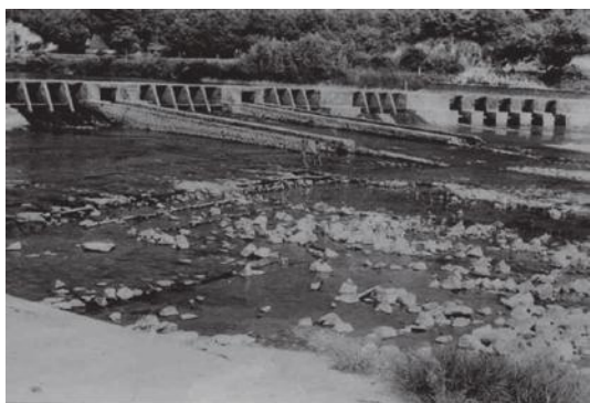
石造り石堤(明治用水頭首工)
