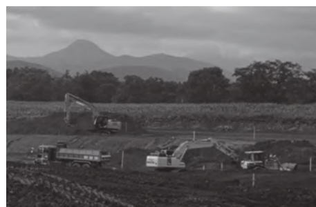
写真-2 阿寒第6工区 基盤造成工の施工状況
