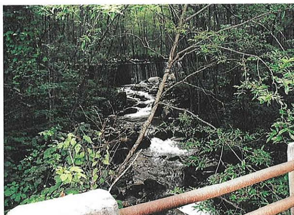
写真-1 H橋よりOP川上流方向を見る
