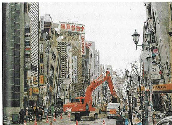
写真－2 傾いたビル群(神戸市中央区) 2)
